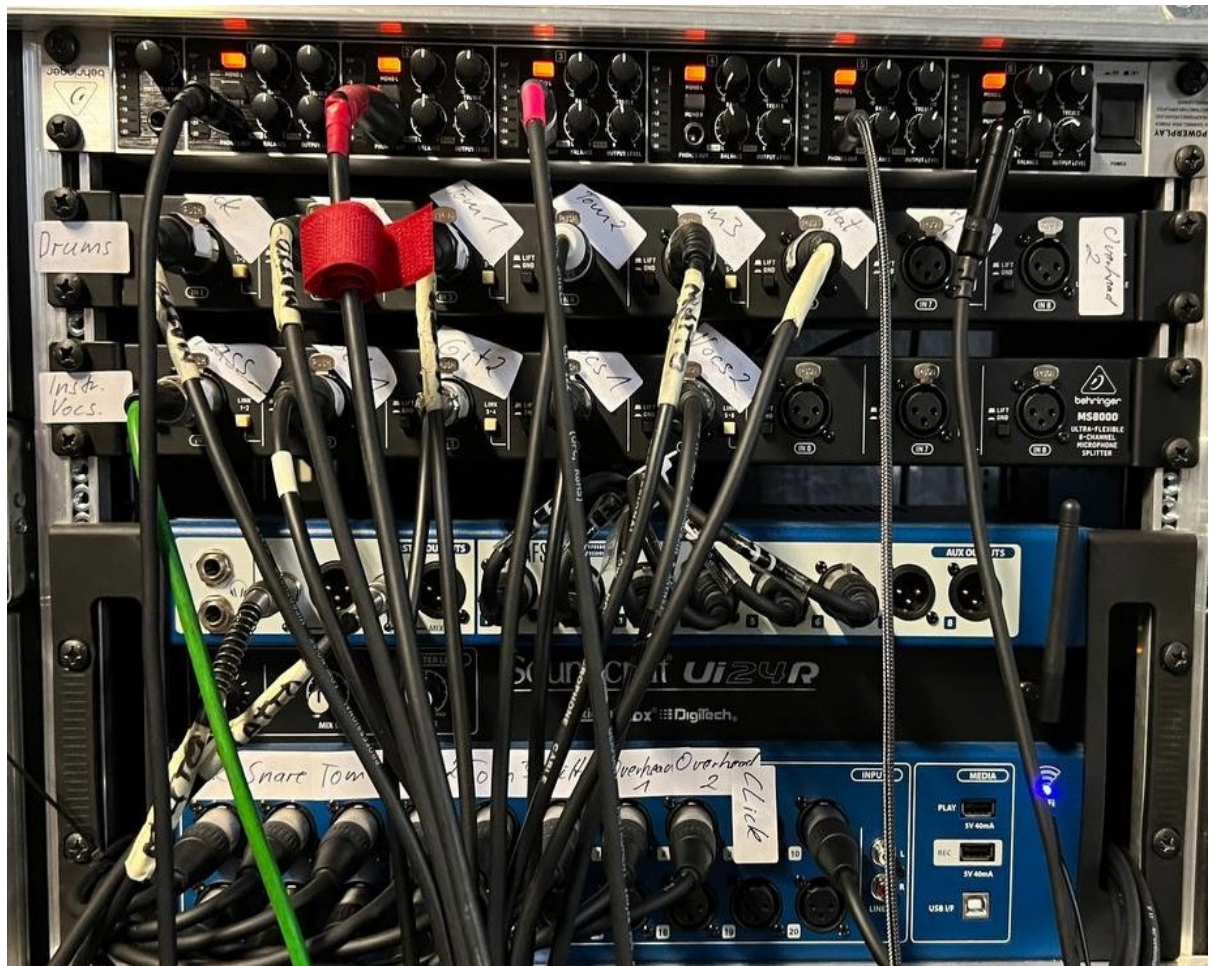
Schaubild 1: Rack mit Kopfhörerverstärker (oben), Splitbox 1 für Drum-Mikrofonierung (darunter), Splitbox 2 für Instrumenten- und Vocal-Mikrofonierung (Mitte) und Soundcraft UI24R (ganz unten, blau).
